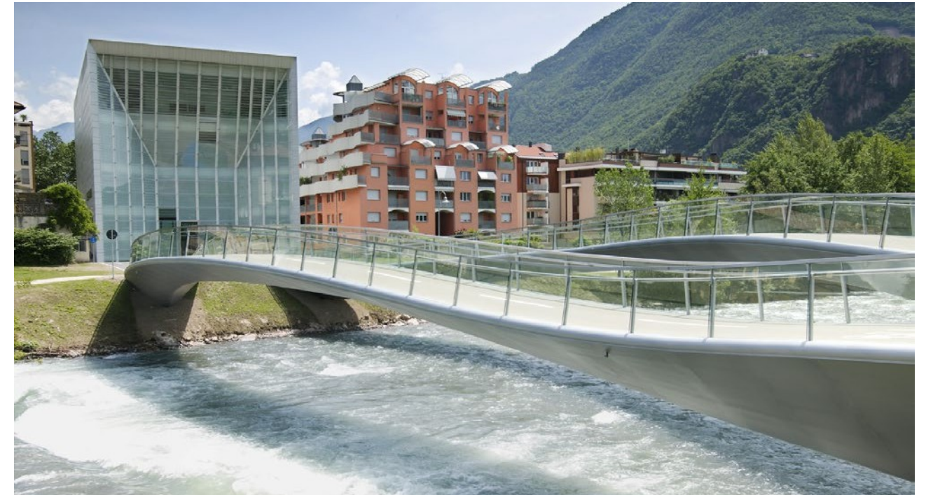
Пешеходный мост через реку Эйзак Больцано, Италия, 2008 год
