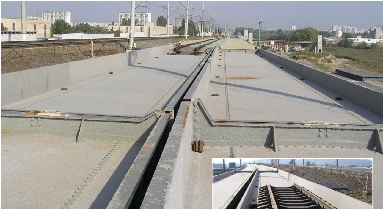
Железнодорожный мост через реку Днепр Киев, Украина, 2007 г.
